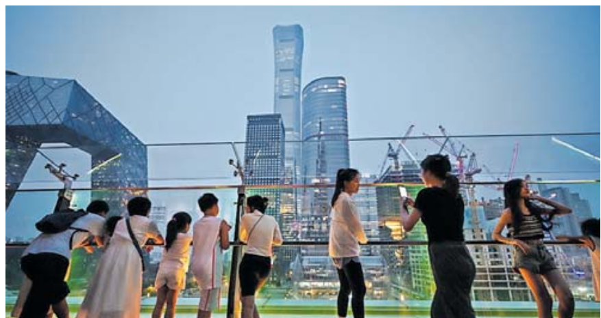
Hinter den Fassaden warten jede Menge Baustellen: die Skyline des zentralen Geschäftsviertels von Peking.
